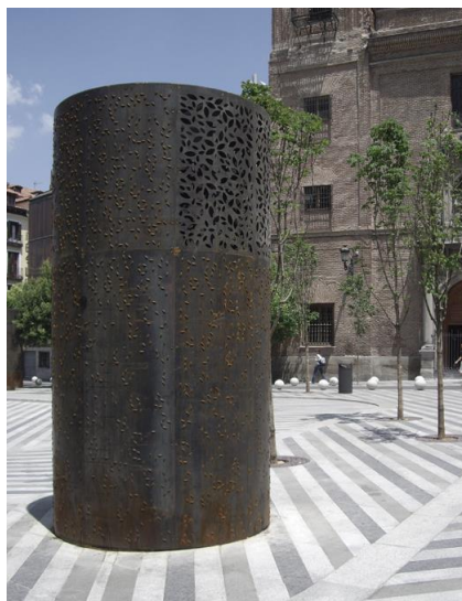
Foto 8. Pozo de ventilación – salida escaleras y ascensor
